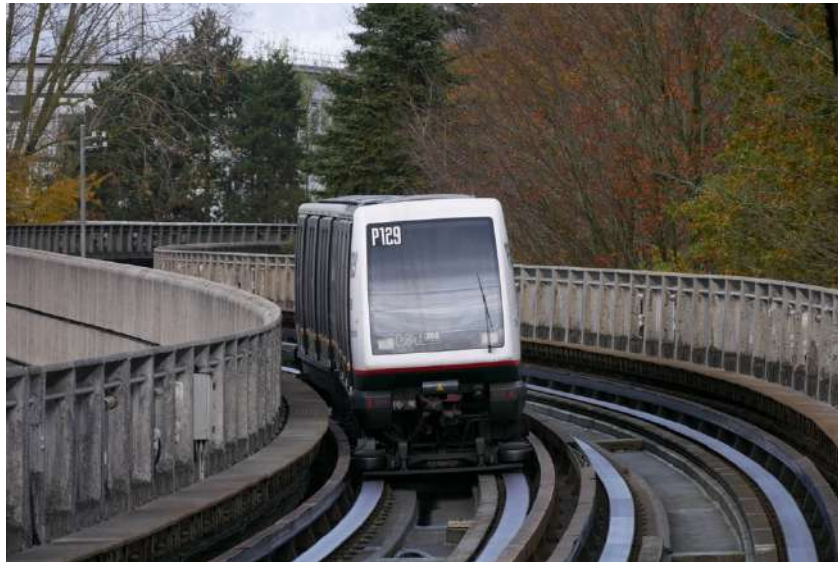
Une rame VAL 208 en circulation le dimanche 17 novembre 2024, jour d'inauguration du nouveau pilote automatique d'Alstom à proximité de la station 4 Cantons Stade Pierre Mauroy.
